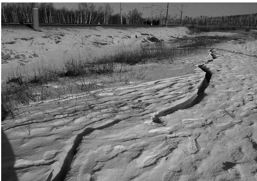
Рис. 1. Бугор наледи вдоль насыпи железной дороги (высота 2,5 м, март 2014 г.)
